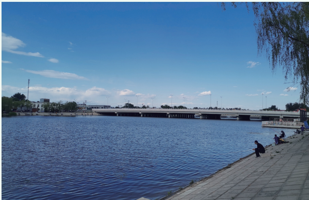
在马房桥旧址附近新修建的上庄水库大桥（作者供图）
