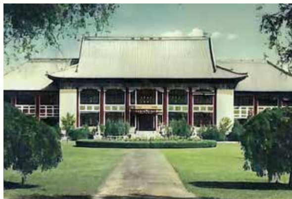
完工后的贝公楼（作者供图）
